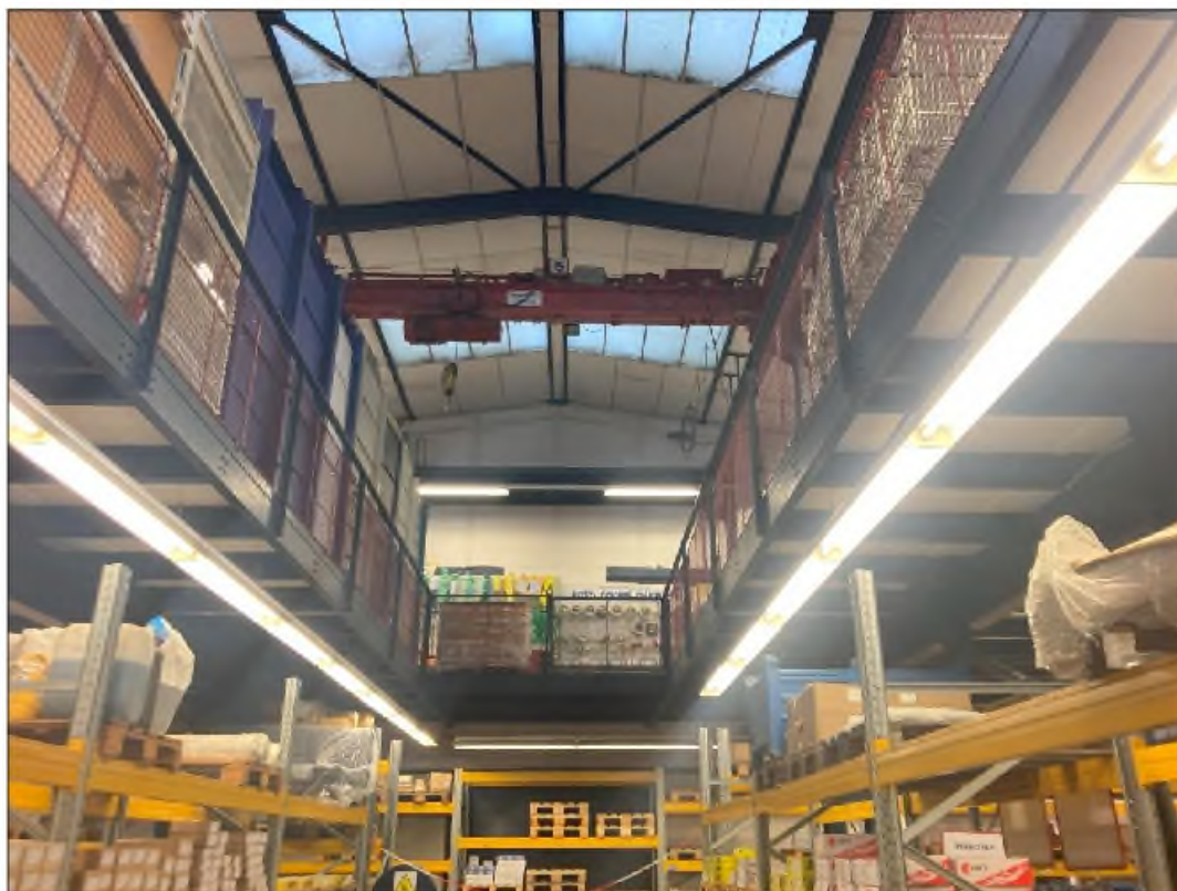
Obr. č. 7 Průzor z 1.NP na galerii 2. NP a pohled na střešní a jeřábovou konstrukci [zdroj: vlastní; místní šetření ze dne 7. 3. 2024]
