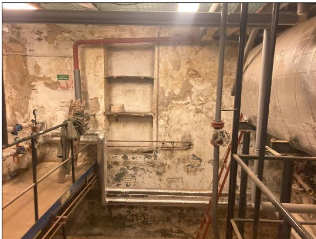
Obr. č. 17 Technická místnost v 1. PP; přístup pouze z exteriéru [zdroj: vlastní; místní šetření ze dne 7. 3. 2024]
