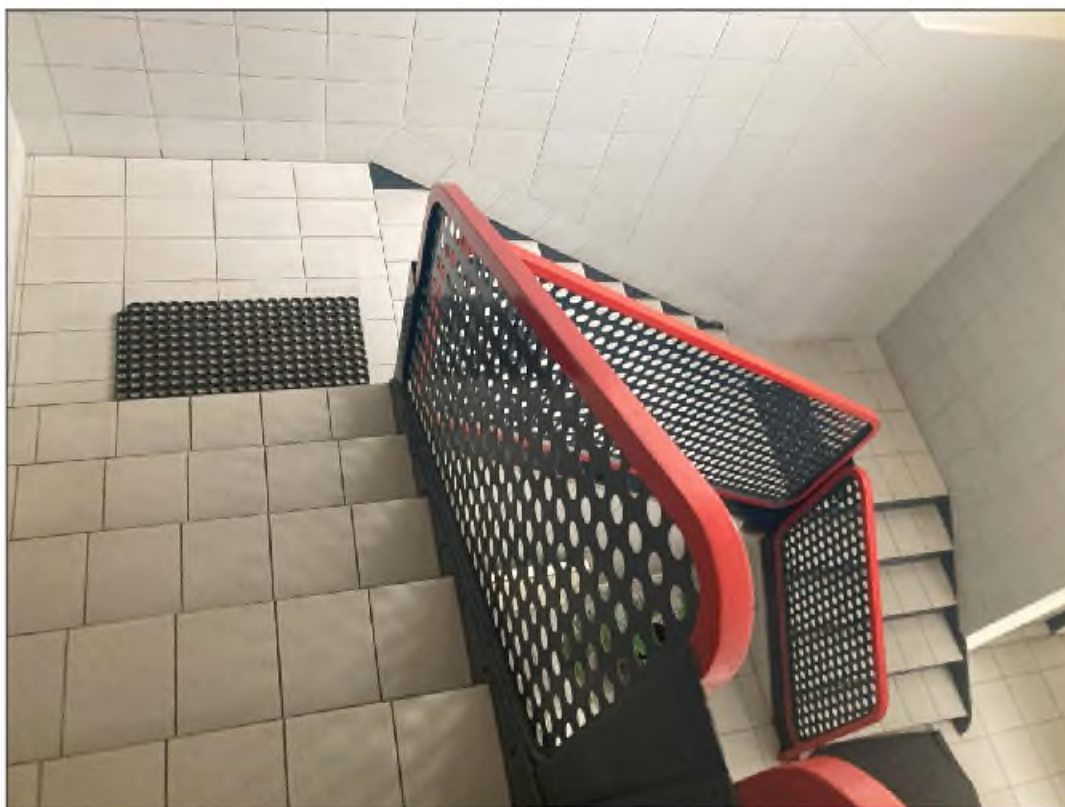
Obr. č. 14 Schodišťový prostor ve vyzdívané části haly [zdroj: vlastní; místní šetření ze dne 7. 3. 2024]
