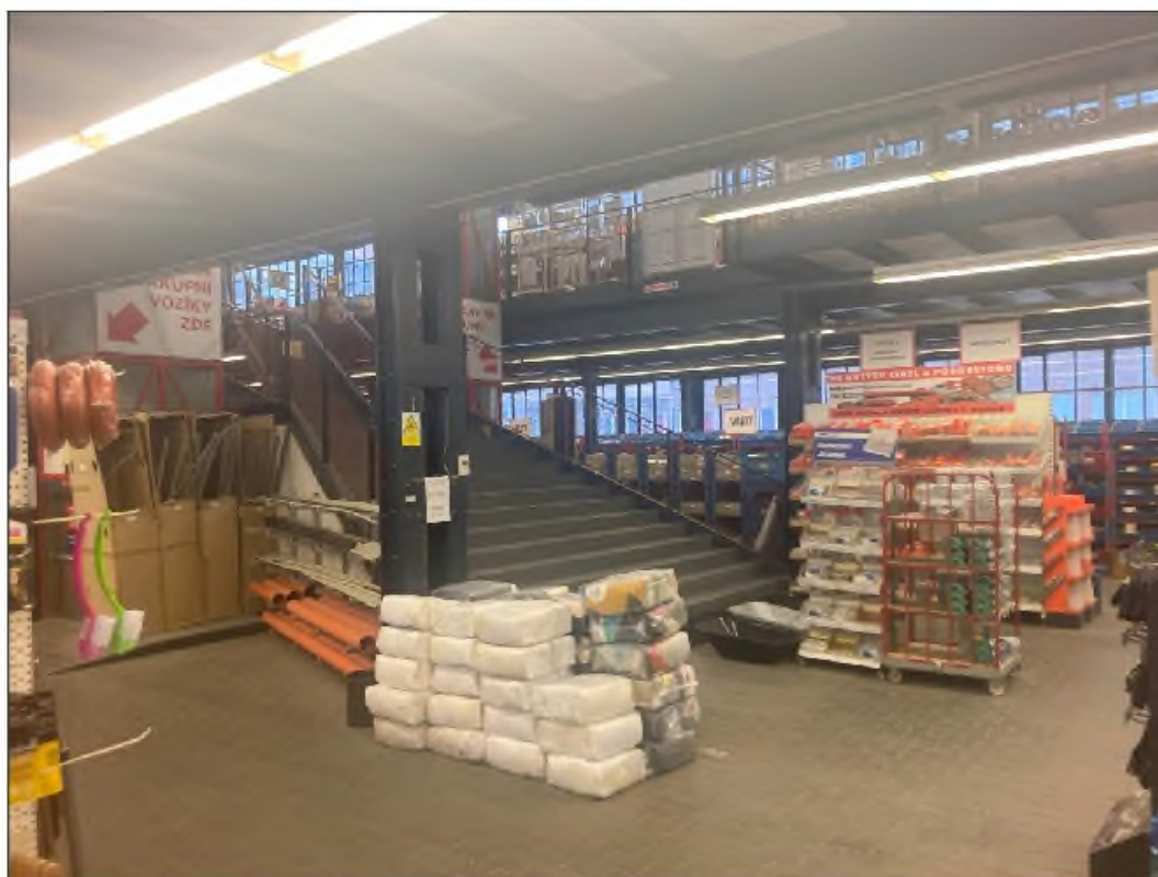
Obr. č. 6 Provozní plocha haly v 1. NP se středovým ocelovým schodištěm [zdroj: vlastní; místní šetření ze dne 7. 3. 2024]
