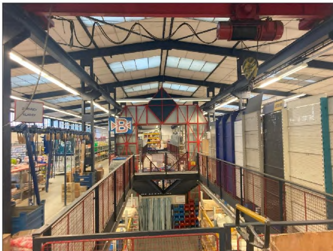
Obr. č. 10 Pohled na vnitřní prostor haly přes obě podlaží [zdroj: vlastní; místní šetření ze dne 7. 3. 2024]
