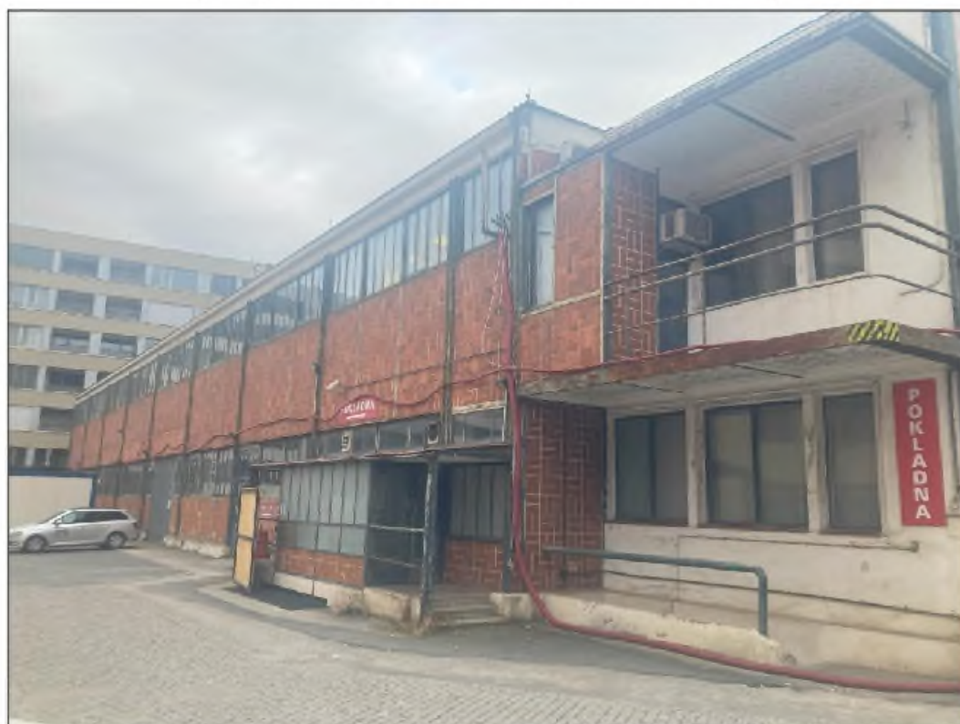
Obr. č. 2 Jihozápadní pohled na celou halu na ulici U Pergamenky č. p. 1455/11 [zdroj: vlastní; místní šetření ze dne 7. 3. 2024]
