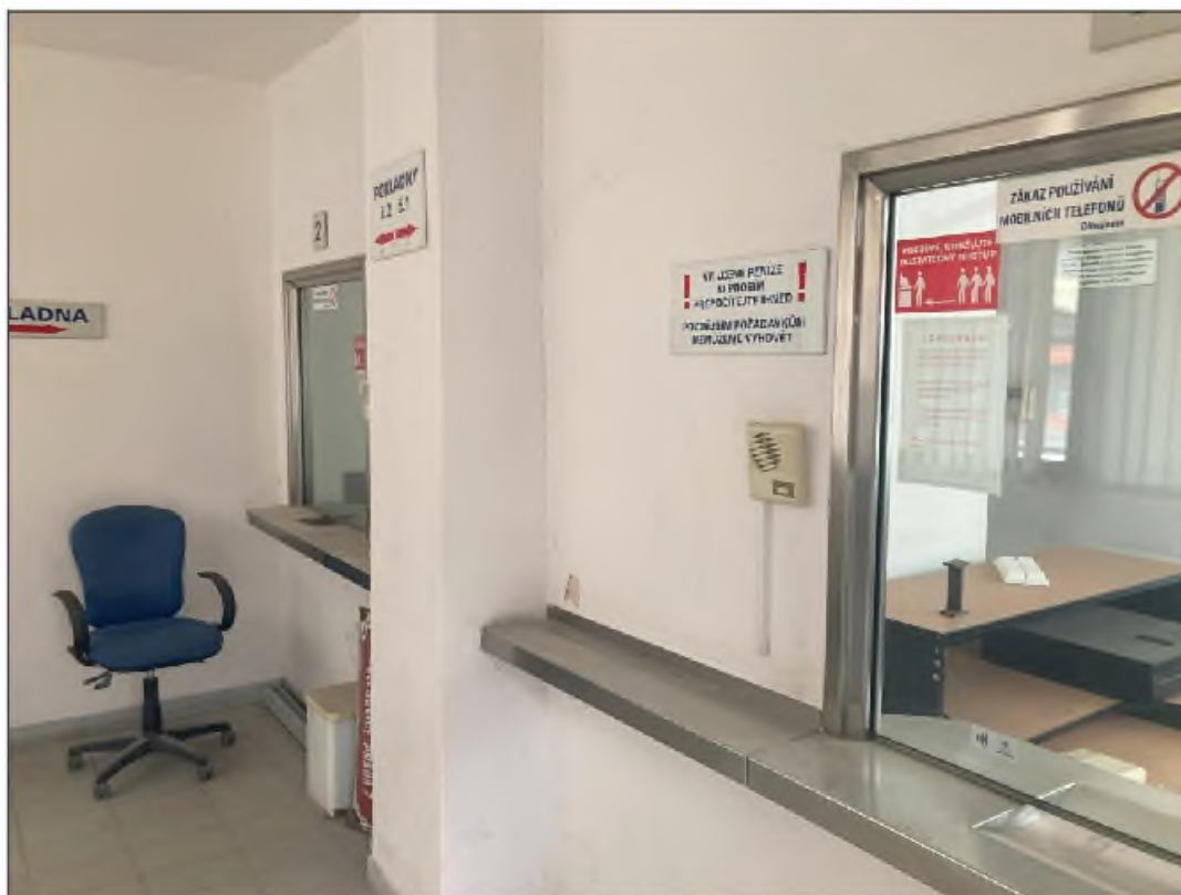
Obr. č. 18 Prostor vrátnice a pokladen v 1. NP; přístup pouze z exteriéru [zdroj: vlastní; místní šetření ze dne 7. 3. 2024]
